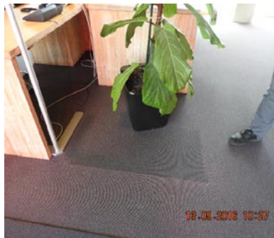
Foto 2 zeigt beispielhaft den Farbunterschied zwischen einer unverlegten, in einem dunklen Raum gelagerten Originalprobe und dem der UV-Lichteinwirkung ausgesetzten Flächenbelag.
