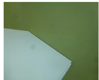
Wie das abschließende Foto 6 zeigt, hat die Farbveränderung z.B. unter einer über einen längeren Zeitraum offen stehenden Tür und hier unter dem Türblatt nicht stattgefunden, da UV-Lichteinwirkung durch das Türblatt verhindert wurde.
