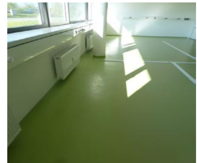
Wie das abschließende Foto 6 zeigt, hat die Farbveränderung z.B. unter einer über einen längeren Zeitraum offen stehenden Tür und hier unter dem Türblatt nicht stattgefunden, da UV-Lichteinwirkung durch das Türblatt verhindert wurde.
