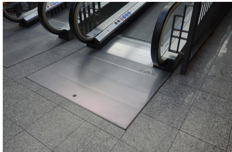
Bei Rolltreppen ist ein schwellenloser Übergang zwingend erforderlich
