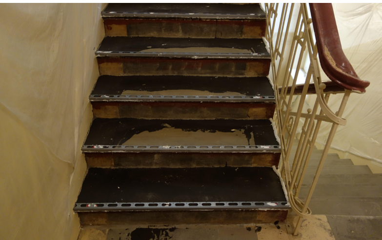
Bei der Treppensanierung ist auf eine schwellenlose Ausführung zwingend zu achten
