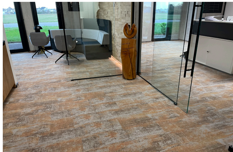
Besonders bei Glastüren darf es keine Höhenversätze und grössere Unebenheiten geben
