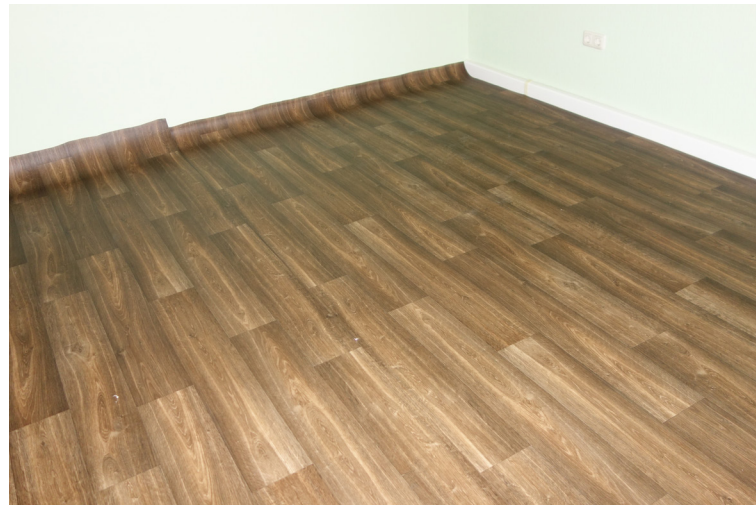
Lose Auslegung des neuen CV-Belages auf den gereinigten PVC-Designbelag
