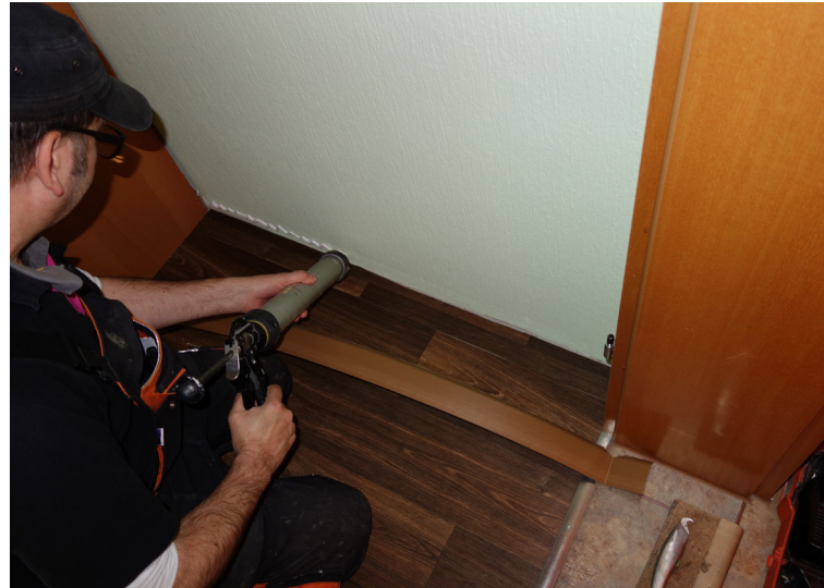
Montage der Sockelleisten mit einem lösemittelfreien Montagekleber
