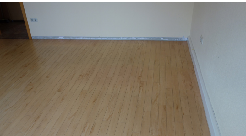
Die alte Sockelleiste wurde entfernt, die für die Heizungsrohre blieb erhalten
