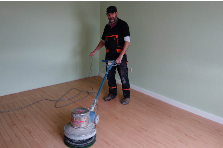
Intensive Grundreinigung des alten PVC-Designbelages
