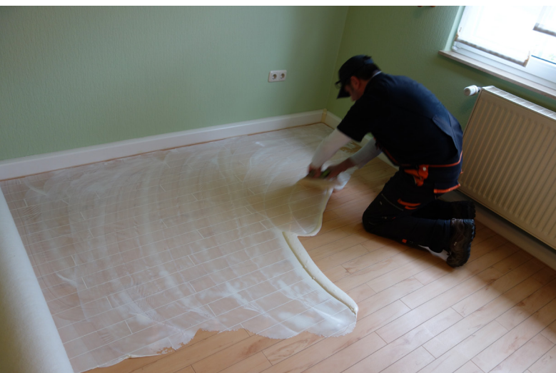
Auftragen des Dispersionsklebers auf den mit einer Weichmachersperre versehenen alten PVC-Designbelag
