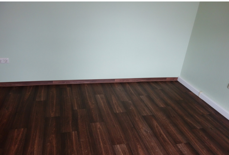
Fertig verlegte CV-Belagsfläche mit einer neuen Sockelleiste
