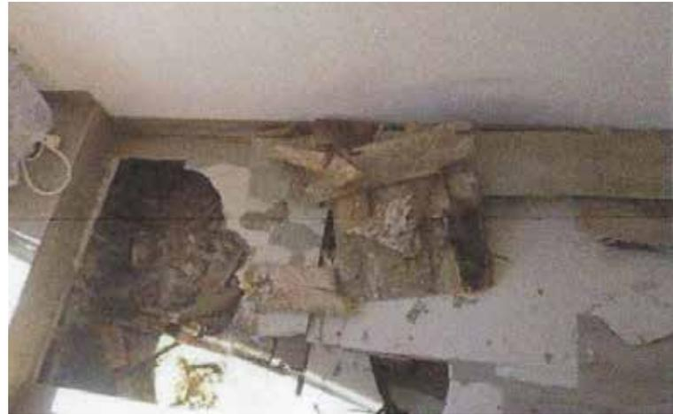
Feuchteschaden an einer erdberührten Holzkonstruktion
