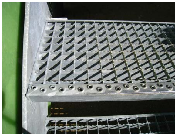
Abbildung 24 Sägezahnartige Ausbildung eines Rostes
