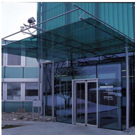
Abbildung 30 Hauseingang mit Wetterschutz
