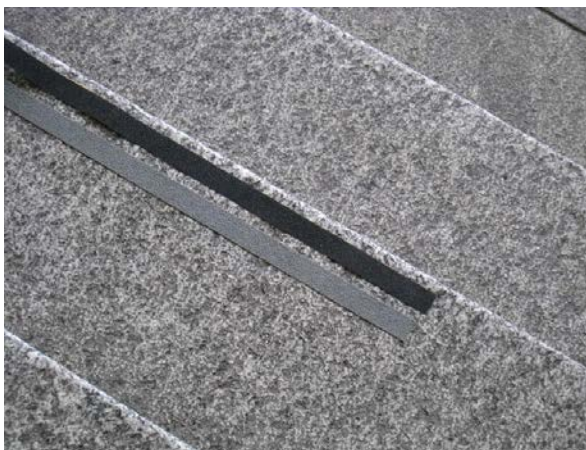
Abbildung 27 Antirutsch-Bänder machen auf Treppenkanten aufmerksam
