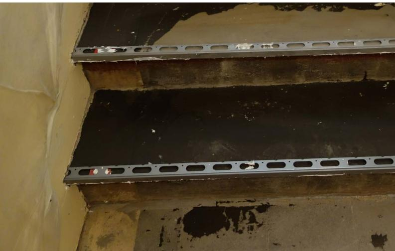
Metallprofile an den Treppenkanten erhöhen deren Stabilität
