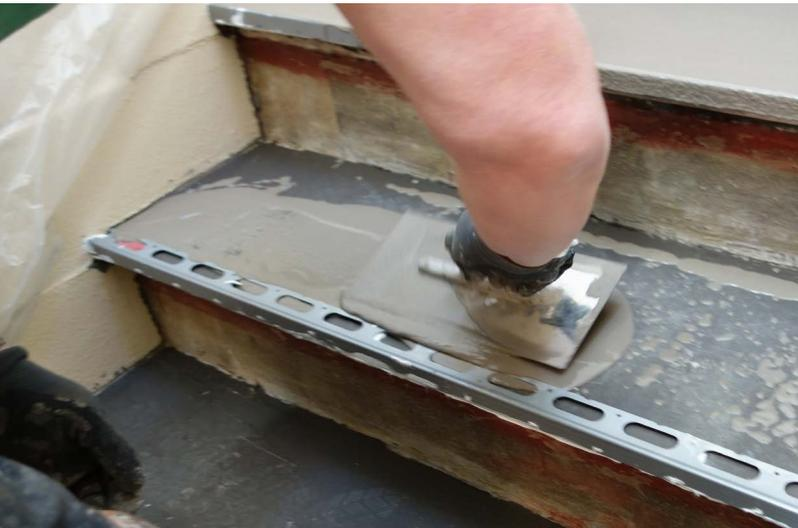
Ausgleichen der Trittstufen mit einer geeigneten Spachtelmasse
