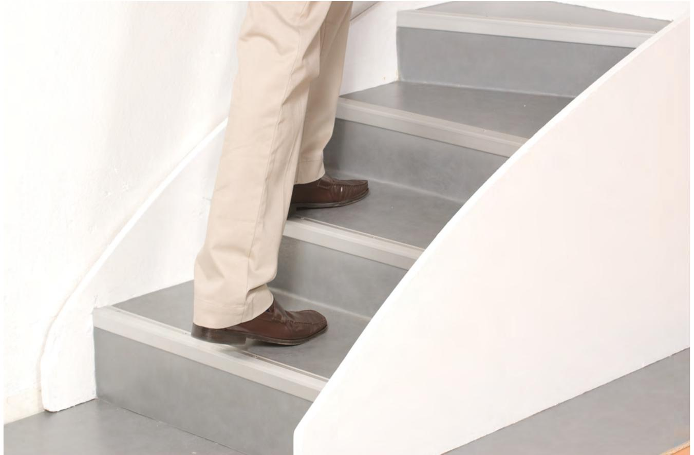
Oben: Treppenlösungen mit elastischen Bodenbelägen sorgen für mehr Sicherheit und gute Trittschalldämmung im Treppenhaus. Foto: Tarkett
