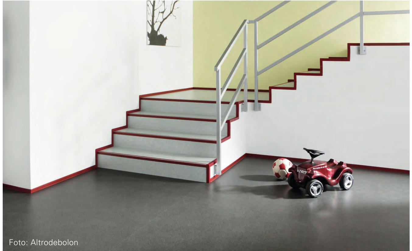
Übergang an der vorderen Trittkante, damit das Treppenkantenprofil komplett aufliegt und bei Belastung keine vertikalen Bewegungen aufweisen sowie nicht überdehnt werden kann.
