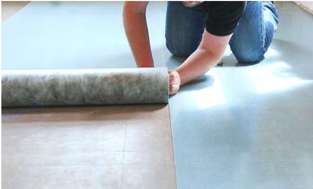
Sanierungsunterlage für LVT Dryback Verlegung auf PVC-Alt-Belag
