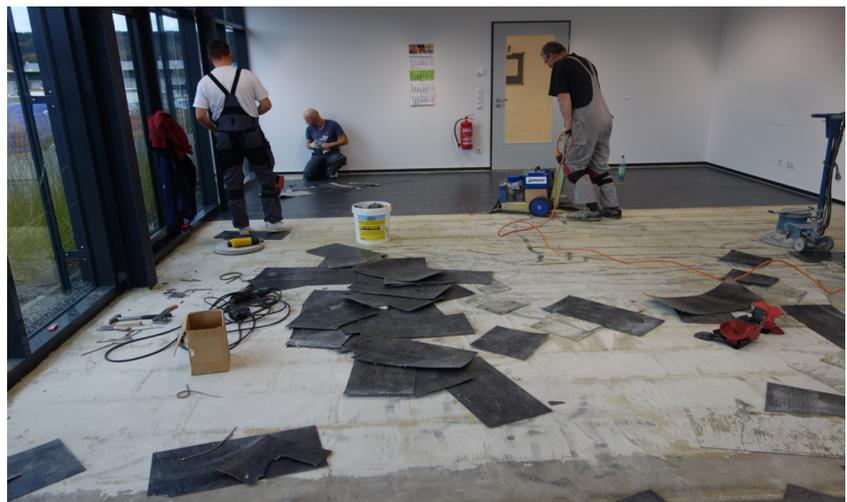
Aufgrund mangelhafter Klimatisierung mussten die Designbeläge entfernt werden.
