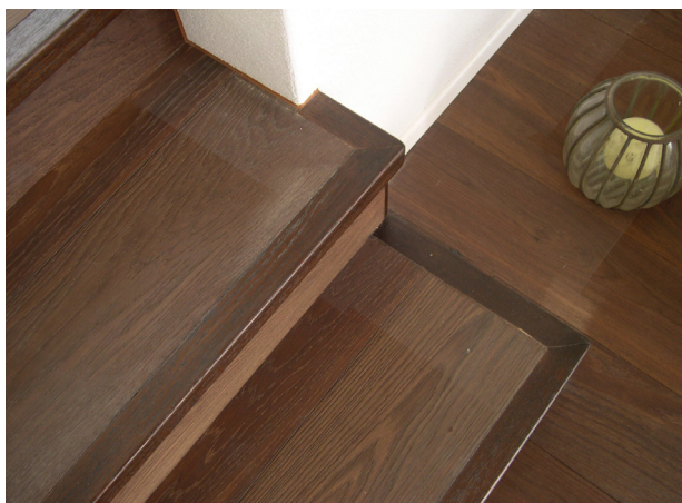
Treppenrandzonen ebenso mit heller Farbe
