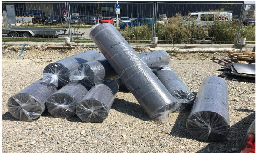
**Abb. 3 - Eine optimale Lagerung und Temperierung der Materialien ist in der Baustellenpraxis häufig nicht machbar.**
