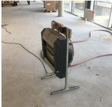
**Abb. 2 Baustellenheizung - Auf vielen Grossbaustellen ist im Winter kein zuverlässiger Heizbetrieb sichergestellt.**
