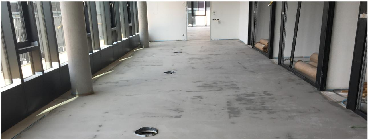
**Abb. 1 Das Raumklima übt einen entscheidenden Einfluss auf das Trocknungsverhalten von Estrichen aus.**
