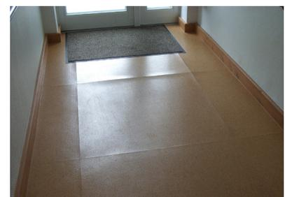
**Abb. 4 - Dieser Bodenbelag wurde bei ungeeigneten bauklimatischen Bedingungen verlegt.**
