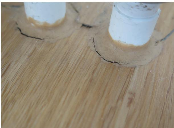
Anschlussfugen gefüllt mit Fugenkitt
