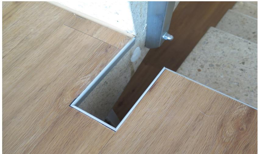
Satter Anschluss an Abschlusswinkel ohne Bewegungs- / Anschlussfugen
