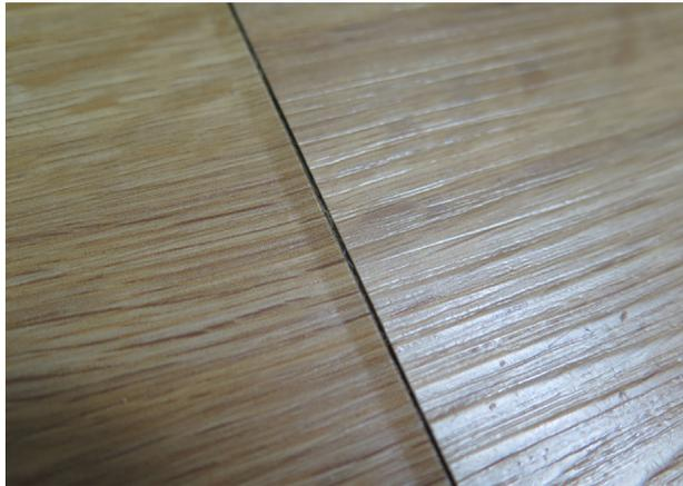
Zusätzlich zur Kantenaufwölbung treten auch Fugen auf im Stirnstoß
