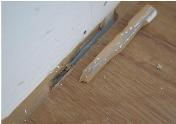
Harter Fugenkitt, eingefüllt über die ganze Bodenbelagshöhe
