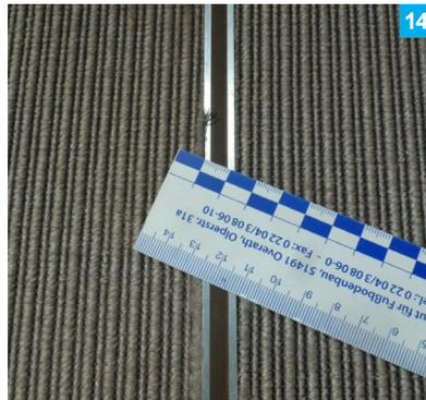
Auch bei textilen Bodenbelägen und insbesondere Flachgeweben ist aufgrund der besonderen Rückenkonstruktion darauf zu achten, dass zum einen eine ausreichende Klebstoffmenge verwendet wird und zum anderen der textile Bodenbelag rechtzeitig in das Klebstoffbett eingelegt und angewalzt wird. Andernfalls ist eine unzureichende Benetzung der Belagrückseite mit Klebstoff einhergehend mit einer nicht funktionstauglichen Klebung vorprogrammiert, wie abschliessendes Foto 15 zeigt.
