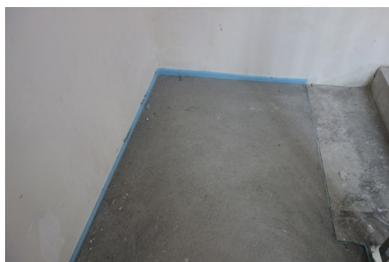
Fussbodenbewegungsfugen müssen genau auf den Verwendungszweck hinsichtlich der Lage, der Breite, der Verfüllung und der Ausbildung in einen Oberbelag abgestimmt und geplant werden. Dabei ist die endgültige Lage der Fugen vor der Ausführung durch den Bauwerksplaner in Abstimmung mit allen
