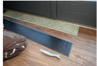
Foto 12 zeigt ein Beispiel, bei welchem die Belagsherstellerin zum Bodenbelag eine alukaschierte Unterlage mit zusätzlicher Klebstoffbeschichtung anbietet, jedoch eine abweichende Unterlage mit Alukaschierung ohne zusätzliche Klebstoffbeschichtung verarbeitet wurde.
