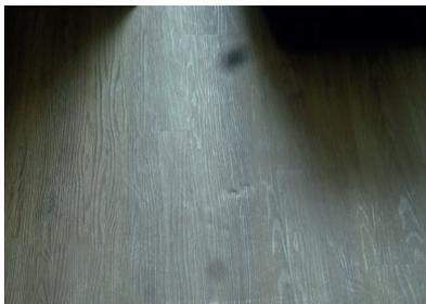
Die Unterlage wurde nicht – den Herstellerangaben gemäß – auf der Oberfläche zusätzlich gespachtelt. Die Folge sind signifikante, bis zu > 1mm tiefe Druckstellen und Verformungen des Bodenbelages insbesondere durch statische Belastungen, verursacht durch übliche Möbel und Einrichtungsgegenstände, wie beispielhaft nochmals nachfolgendes und abschließendes Foto 14 zeigt.
