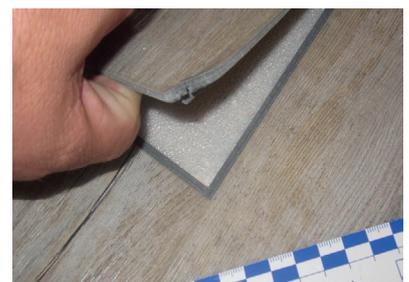
Auf Foto 7 ist dargestellt, dass Unterlagen nicht für den Ausgleich von Unebenheiten geeignet sind und somit eine Untergrundvorbereitung auch nicht ersetzen können. Überbrücken die LVT – Planken anfangs noch vorhandene Unebenheiten und scheinen diese zu kaschieren, so werden sich die LVT - Planken durch ihre thermoplastischen Eigenschaften später im Rahmen der Nutzung den Konturen und somit Unebenheiten des Untergrundes anpassen.
