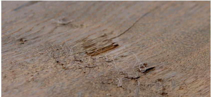
bezeichnen, teilweise werden große Längsrisse durch das Füllen mit dunklem Kittmaterial geradezu betont. Ebenso werden Äste ausgekittet.
