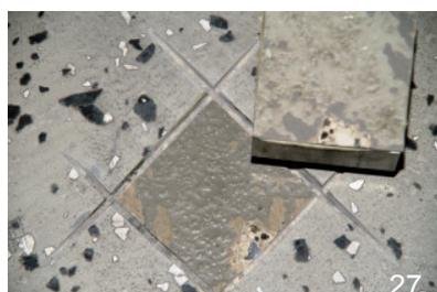
Ungenügende Oberflächenzugfestigkeiten des Untergrundes, aber auch vorhandene labile Zonen und Restschichten können in der Praxis schnell zu großflächigen Ablösungen des Kunstharzbeschichtungssystems vom Untergrund führen, wie die Bilder 28 bis 31 zeigen.
