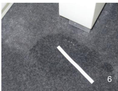
Folgerichtig ist im Rahmen der Innenausbauarbeiten Schmutz und Baustaub in einem erheblichen Maße auf die Oberfläche des Nadelvliesbodenbelages gelangt.
