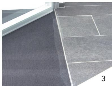
Die Klebstoffrückstände lassen sich im Nachhinein nicht mehr entfernen, ohne dass der textile Bodenbelag auf der Oberfläche Schaden nimmt. Häufig kommt es in der Praxis vor, dass an z. B. textile Bodenbeläge angrenzende Natursteinböden im Rahmen der Bauschlussreinigung gereinigt/gesäubert werden.
