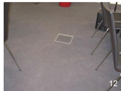
Allein der nachträglich eingebaute Bodentank gibt hinsichtlich der dunkleren Farbe einen deutlichen Hinweis darauf, dass die Nadelvliesbodenbelagebene in einem erheblichen Maße mit Kontaktschmutz (Baustaub etc.) beaufschlagt wurde. Im Rahmen von Reinigungsmaßnahmen konnte schnell festgestellt werden, dass sich in einem erheblichen Maße Kontaktschmutz in der Konstruktion des Nadelvliesbodenbelages befindet, siehe hierzu auch Bild 13.
