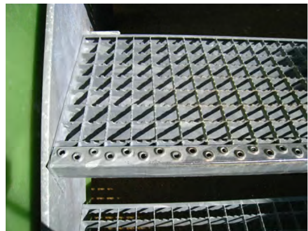
Abbildung 22 Sägezahnartige Ausbildung eines Rostes
