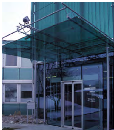
Abbildung 28 Hauseingang mit Wetterschutz
