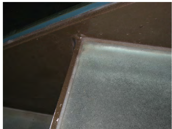
Abbildung 12 Kanten von Einfassungen müssen aufgeraut sein
