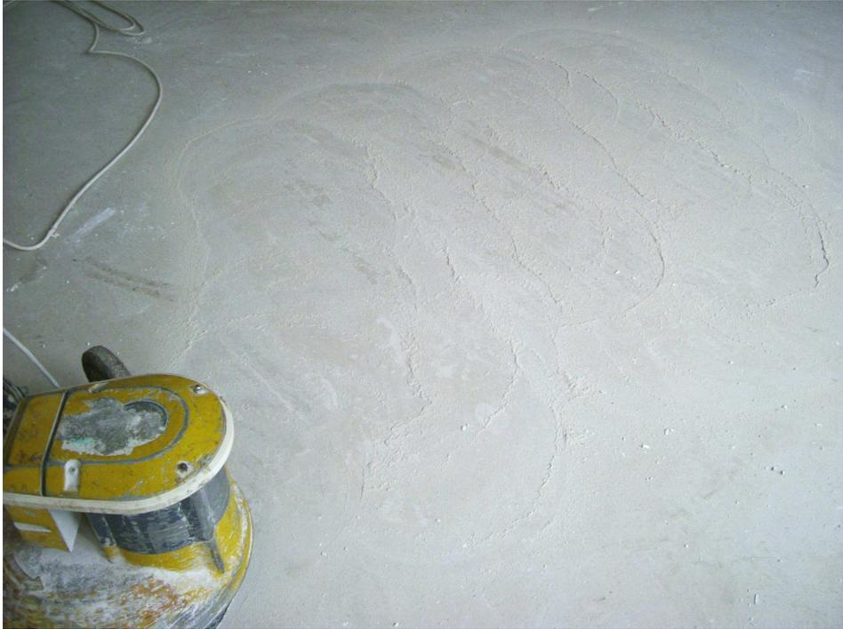
Calciumsulfat-Estriche müssen vor dem Verlegen der Oberbeläge angeschliffen werden, um lose Teile und Schichten zu entfernen.
