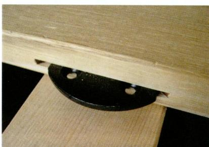
Bei dieser als „Lamello“ bezeichneten Scheibe bleiben die Schrauben auch nach der Montage zugänglich.
