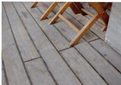
**Vollflächig geklebte Dielen müssen mit einer Spezial-Dichtmasse verfugt werden.**
