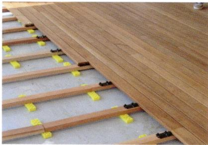
**Gegenläufige Keile werden zum Nivellieren untergelegt. Sie sorgen zudem für eine ausreichende Unterlüftung.**
