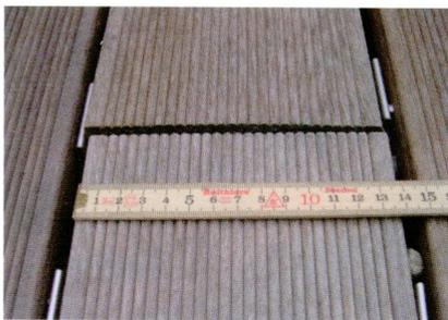
Zu hohe Einbaufeuchte führt zu starkem Schwinden, das die Dielen dann so aussehen lässt.
