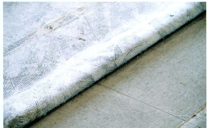
Nach 1 bis 2 Tagen kann der Belag ohne größeren Kraftaufwand abgelöst werden.
