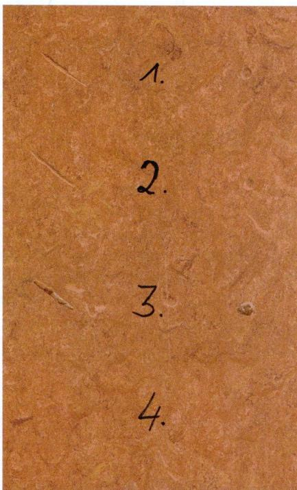
**Das Reparatur-Verfahren wurde an dem Linoleum-Belag Marmorette PUR von Armstrong DLW vorgeführt: Am Anfang steht die Beschädigung des Belages (1.). Es folgt das Flachdrücken der Kanten der Schadstelle (2.). Das vorher gemischte Wachs wird eingebracht (3.). Die reparierte und lackierte Schadstelle (4.) ist fast unsichtbar.**
